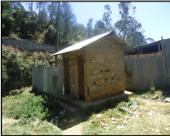
Pic 4.10 unhygienic shared toilet.
