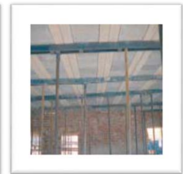
(d) Propping under indicated positions
