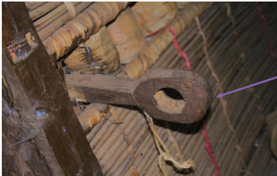
ፎቶ 20:- ቋሚና አግዳሚ መዝጊያ እንጨቶችን ማስገቢያ ሂራቁዋ (Hiraquwaa)
