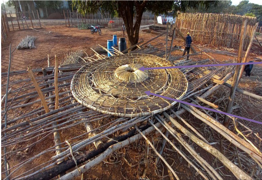
ምንጭ:- በወላይታ ዙን በኦፋ ወረዳ የተሰራው ባህላዊ ቤት ጅምር የጣሪያ ስራ፣ግንቦት2/09/2014 ዓ.ም በአጥኚዋ የተነሳ
