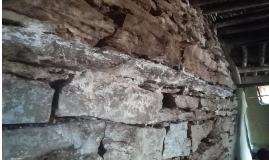
ፎቶ 2፣ በዙቅጡም መስኪድ ግድግዳ ላይ የሚገኝና 3 ሜትር ርዝመት ያለው አንድ ወጥ ረጅም የድንጋይ ቋጥኝ፡፡ (ፎቶ በአጥኚው)፡፡
