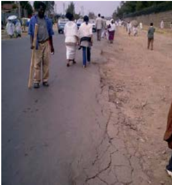
Plate 2.15 Edge Cracks
